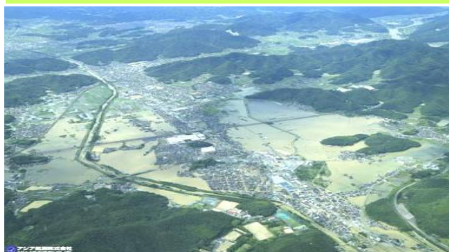
沼田川支流決壊 8 カ所 浸水区域 700ha 状況写真
