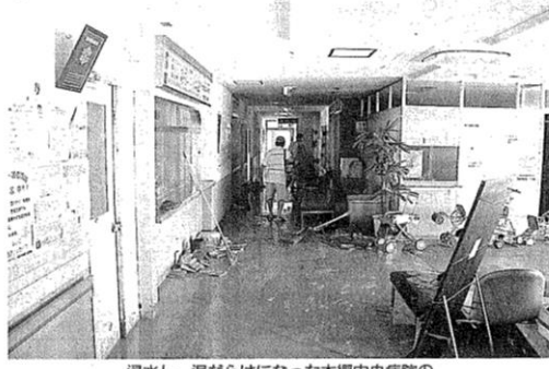
浸水し、泥だらけになった本郷中央病院の1階部分(8日午後0時51分、三原市で)
