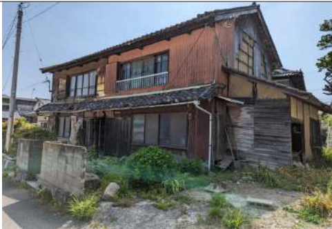
老朽危険空き家除去補助事業 上限50万円/戸補助
